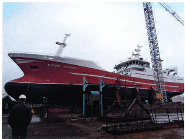
写真2 カーステンセン造船所で建造中のトロール漁船
